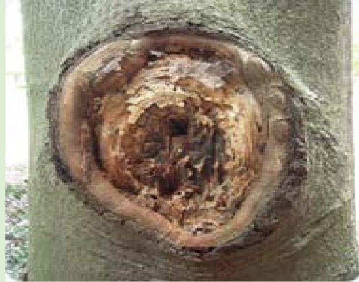
樹幹出現腐爛
